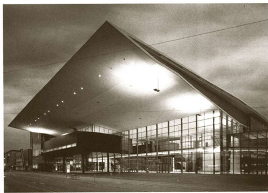
Figura 7: Marcos recubiertos con aluminio en fachadas exteriores de edificios con excelente protección anticorrosiva y efecto de fácil limpieza (hidrofobicidad)
